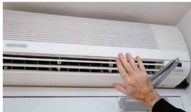
La fluctuation autour de la température programmée peut atteindre \pm 2^{\circ}\text{C} pour un climatiseur classique, elle est d'environ \pm 0,5^{\circ}\text{C} pour un climatiseur Inverter, ce qui procure une sensation de confort plus grande.
