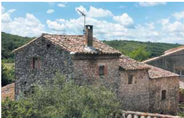
Les murs de pierre épais des maisons traditionnelles du Midi limitent les surchauffes en été.
