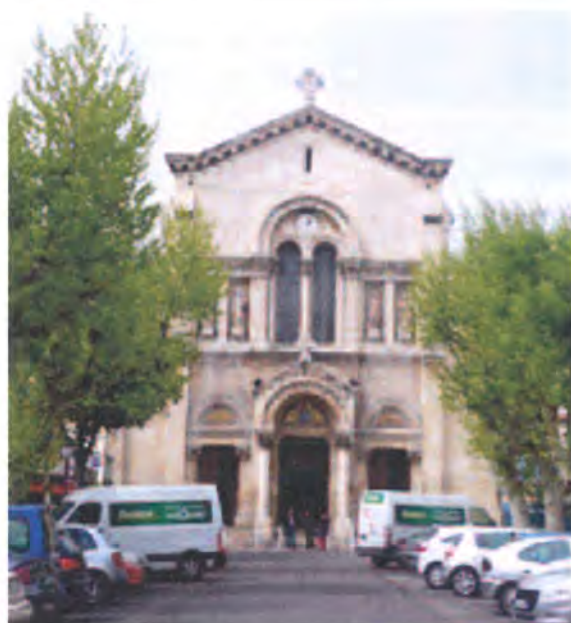
Vue d'ensemble façade principale. ©Claudine Bron, juin 2013
