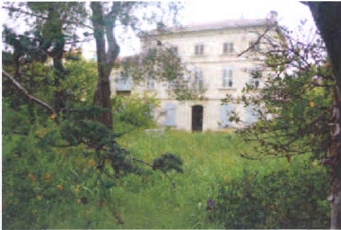
Façade principale Sud ©Claudine Bron, juillet 2013
