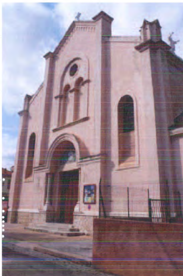
Façade principale Sud. ©Claudine Bron, mai 2013
