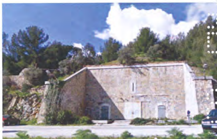
Poudrière, chemin de la Baume, façade d'entrée Est
