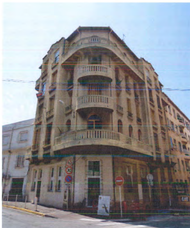
Vue d'ensemble Nord-Ouest. ©Claudine Bron, juin 2013
