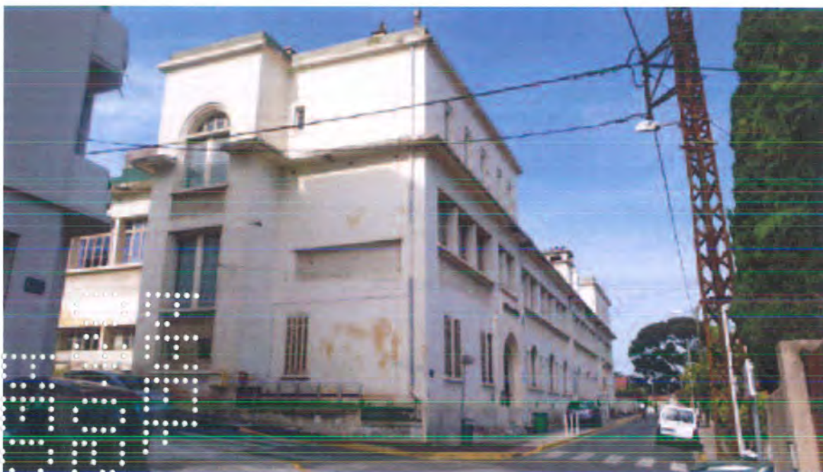
Vue de trois quarts Sud-Ouest. Claudine Bron, juillet 2013
