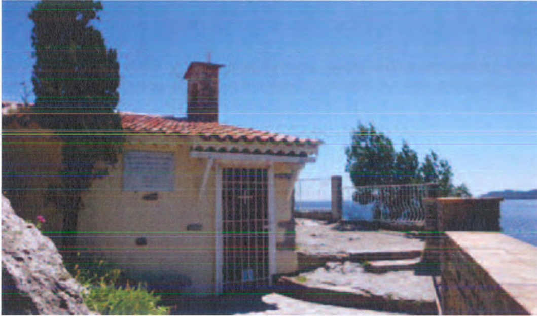
Façade principale Nord-Ouest. ©Claudine Bron, juin 2013
