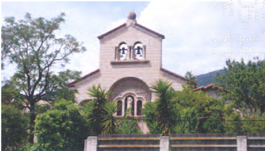
Façade principale Sud, détail parties hautes. ©Claudine Bron, juillet 2013.
