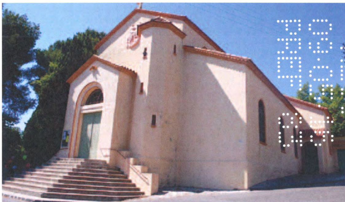
Vue d'ensemble de trois quarts Sud-Est. ©Claudine Bron, juillet 2013
