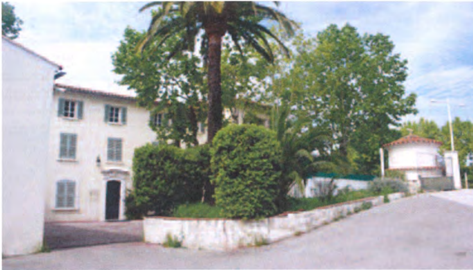
Façade principale Sud. ©Claudine Bron, juillet 2013
