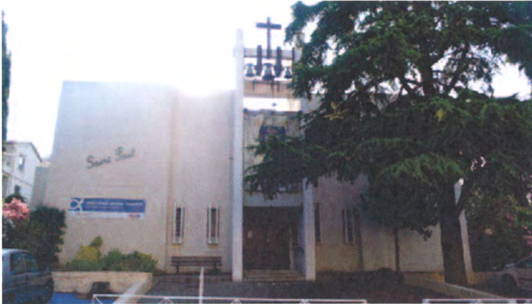
Vue générale, façade principale Est. ©Claudine Bron, juillet 2013
