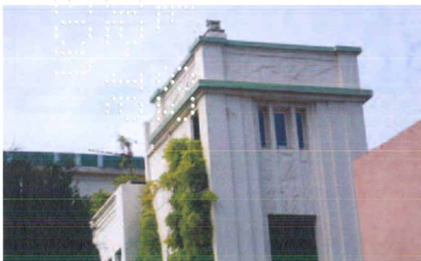
Vue de trois-quart Sud-Ouest. © Claudine Bron, mai 2013
