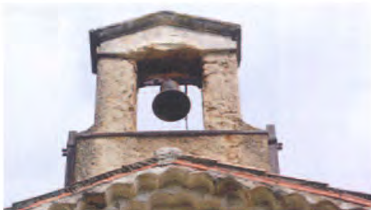
Détail sur clocheton de la façade principale. ©Claudine Bron, juin 2013.
