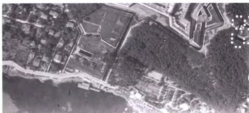
Vue aérienne de la Batterie Basse Lamalgue, en 1927. ©IGN, géoportail, prise de vue ancienne. Droits réservés.
