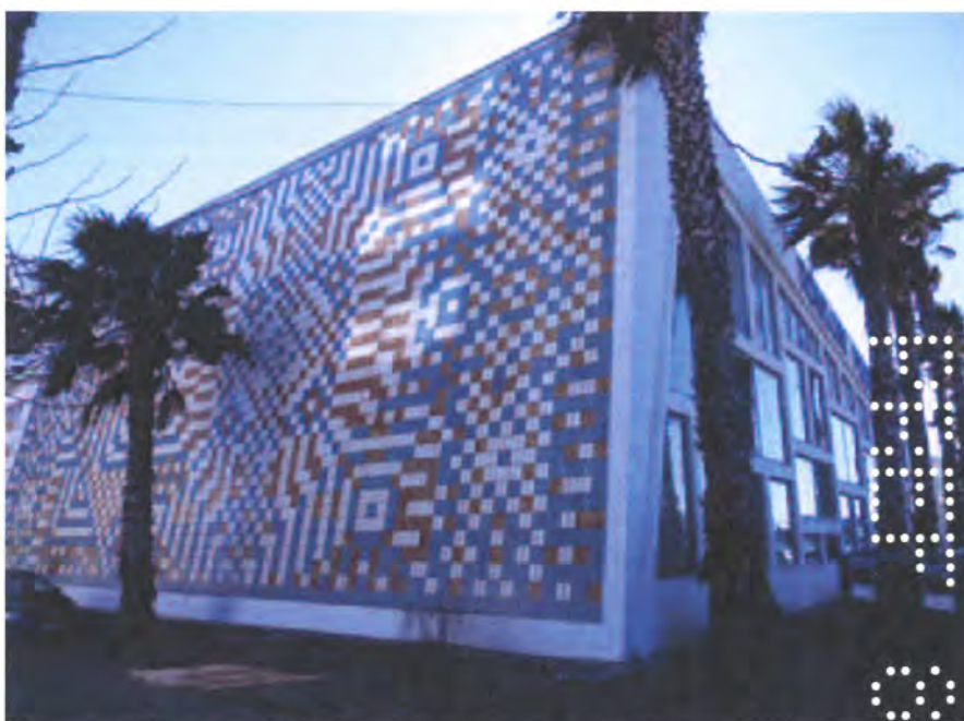
Façade Nord du bassin couvert, détail sur décor monumental de style Pop'Art, en carreaux de céramique de Jean-Gérard Mattio. ©Etudes et Planification Mairie Toulon. Février 2014
