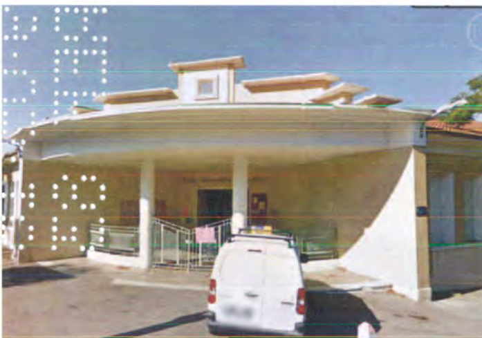
Porche d'entrée Nord-Est. ©Google Earth, 2013
