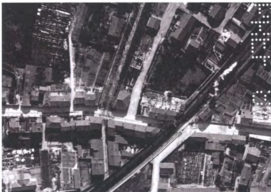
Vue aérienne de la bastide en 1927. ©IGN, géoportail. Droits réservés
