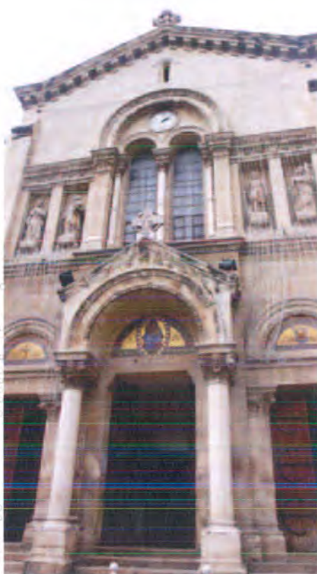
Détail sur porche d'entrée. ©Claudine Bron, juin 2013
