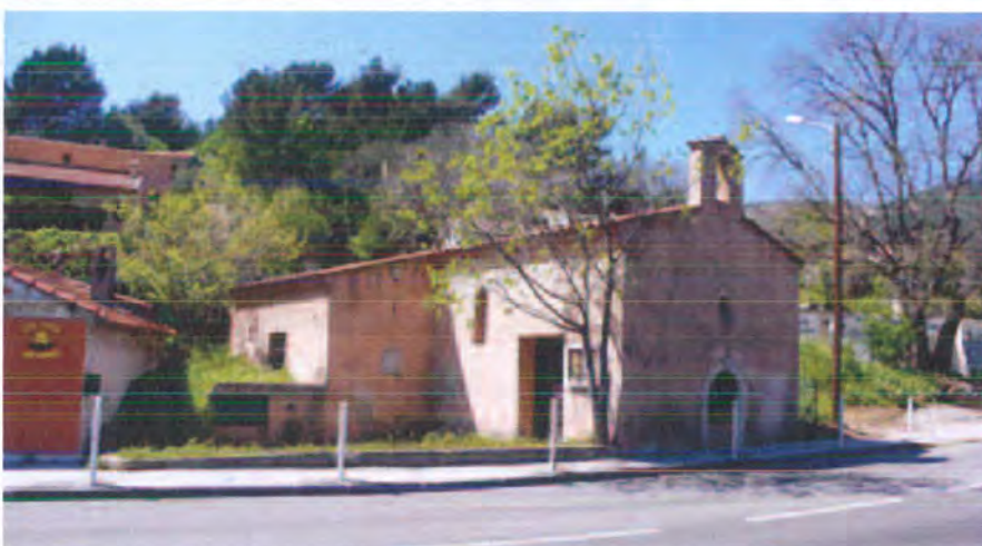
Vue de trois-quarts Sud-Ouest. ©Claudine Bron, mai 2013
