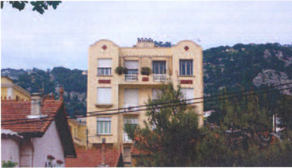
Façade Sud, détail parties hautes. ©Claudine Bron, juin 2013
