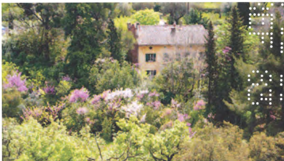
Vue générale façade ouest ©Claudine Bron, juillet 2013
