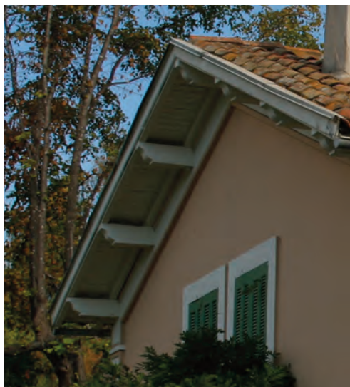
Débord de toit avec poutraison apparente
