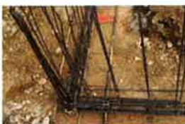
Nœud de chaînage - Continuité mécanique
