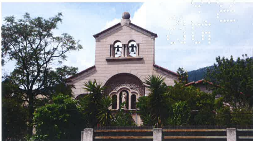
Façade principale Sud, détail parties hautes. ©Claudine Bron, juillet 2013.
