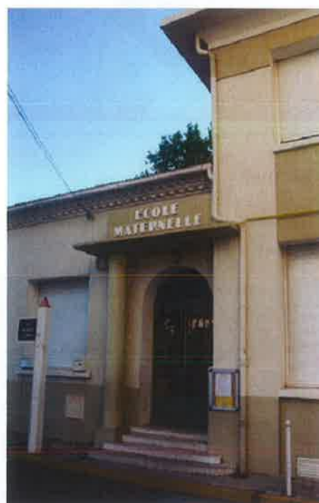
Détail, entrée, façade Est. ©Claudine Bron, juillet 2013
