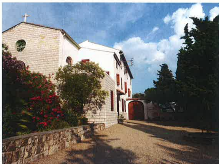
Vue générale de trois-quarts Sud-Ouest. ©Claudine Bron, juillet 2013
