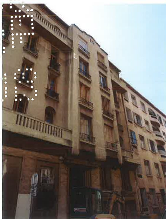
Façade Ouest, détail parties hautes. ©Claudine Bron, juin 2013
