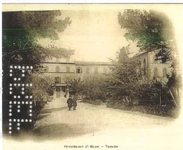
Vue de trois quarts Sud-Ouest. A droite de l'image, on aperçoit sur deux niveaux les fenêtres hautes qui signalent la présence de l'ancienne chapelle. ©Delcampe
