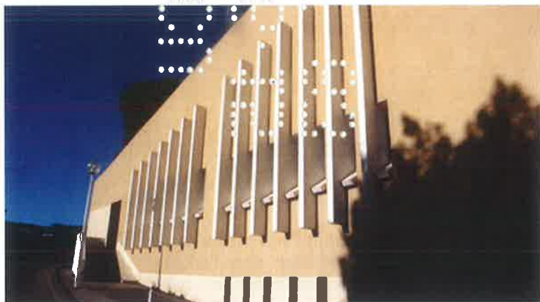
Façade latérale Ouest. ©Claudine Bron, juillet 2013.
