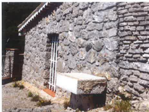
Façade Est autel extérieur. ©Claudine Bron, juin 2013
