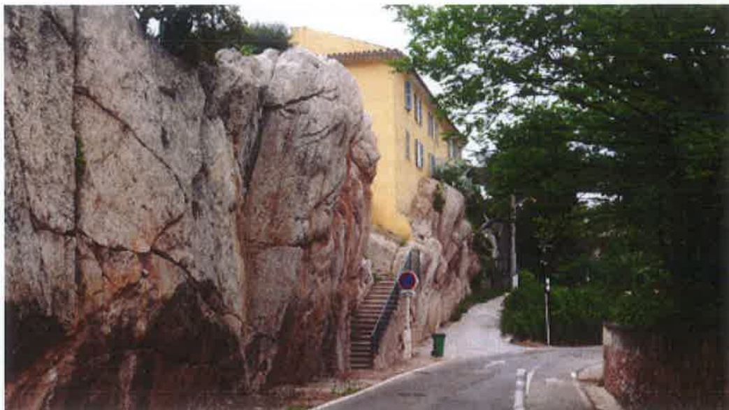
Vue générale façade postérieure Sud. ©Claudine Bron, juin 2013
