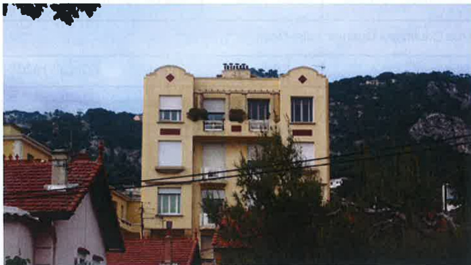
Façade Sud, détail parties hautes. ©Claudine Bron, juin 2013
