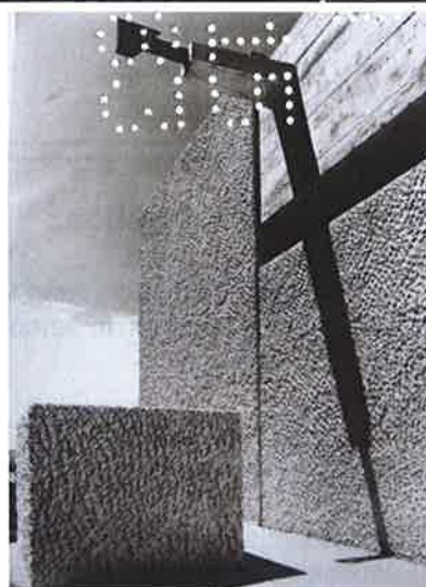
Façade Ouest, détail sur gargouille et réceptacle. ©Société des Amis du Vieux Toulon. Fonds Malausse. Droits réservés.
