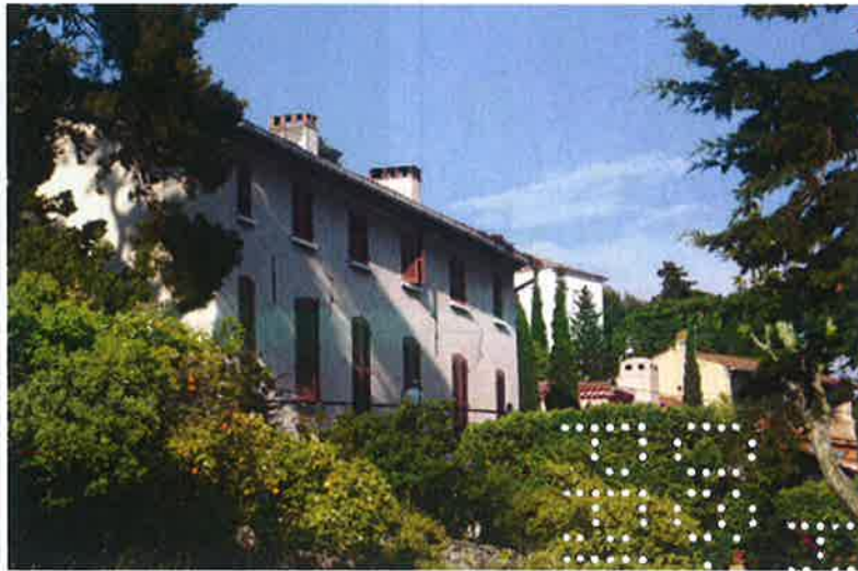
Vue générale façade principale Sud. Claudine Bron, juillet 2013
