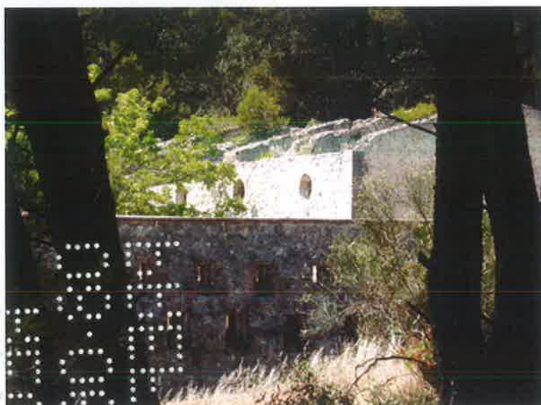
Front Est, double rangée de créneaux de fusillade, au second plan partie haute du bâtiment de casernement. ©Claudine Bron, juillet 2013.
