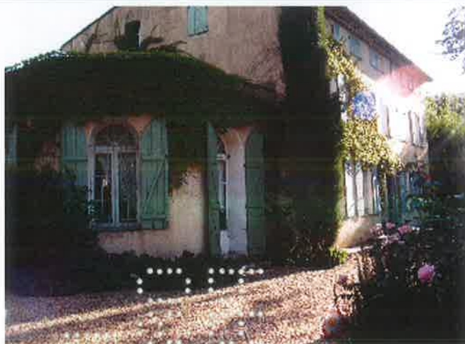
Vue de trois quarts Nord-Est. Au premier plan, l'extension de 1904. ©Droits réservés
