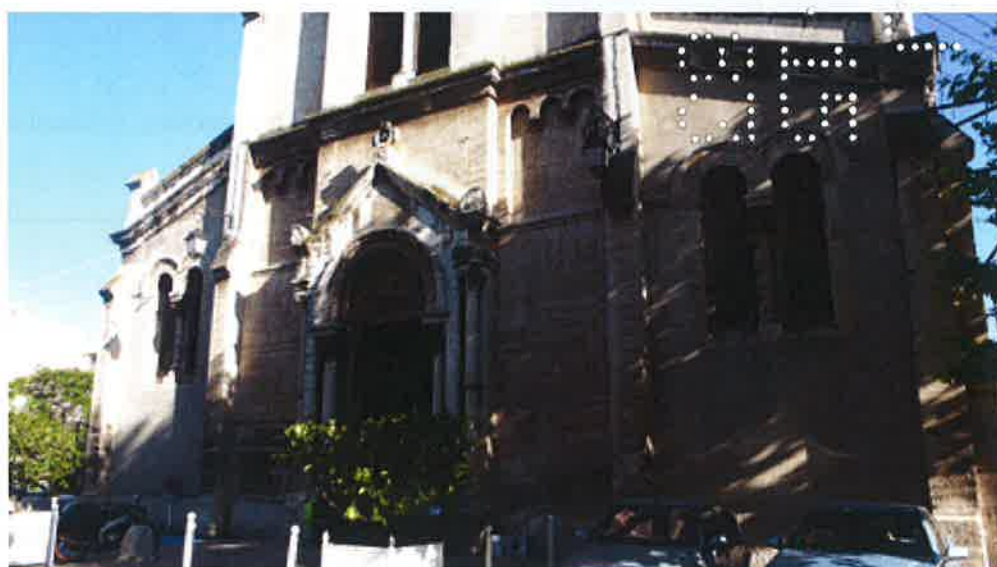
Façade principale Nord, détail partie basse. © Claudine Bron, juin 2013.
