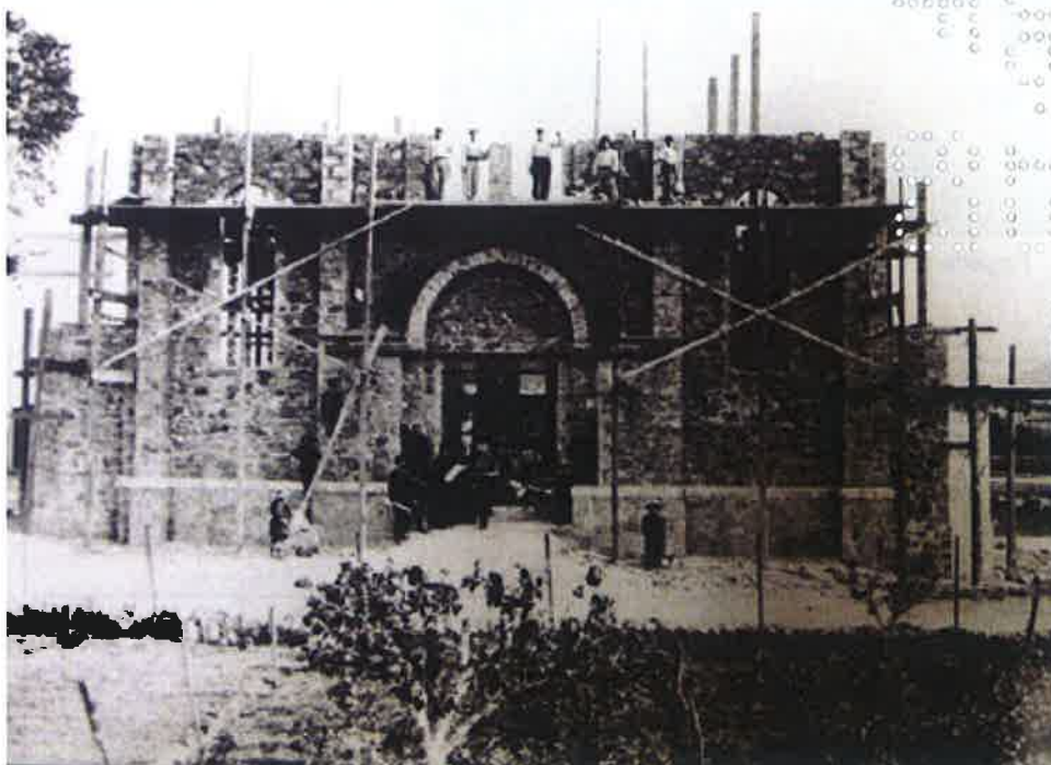
Façade principale en chantier, vers 1911. ©Archives de la Société des Amis du Vieux Toulon. Fonds Malausse
