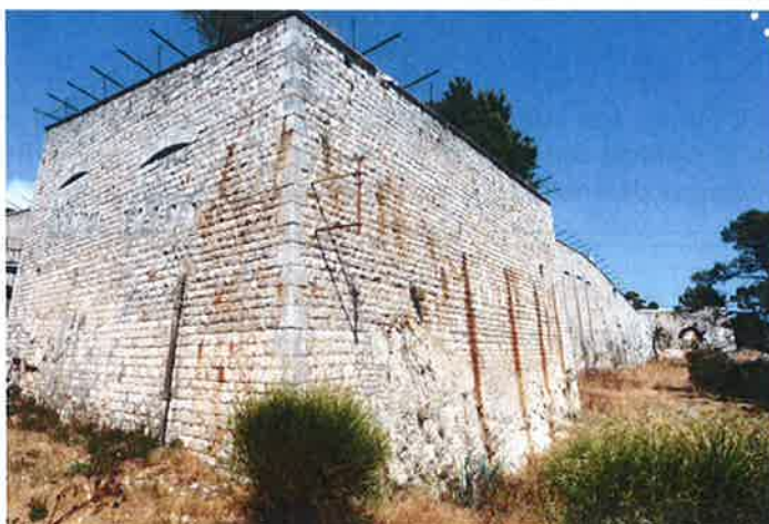
Vue générale de trois-quarts Sud-Ouest. © Claudine Bron, juillet 2013
