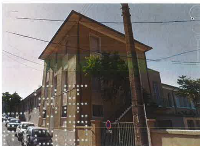
Vue de trois quarts Nord-Ouest. ©Google Earth, 2013
