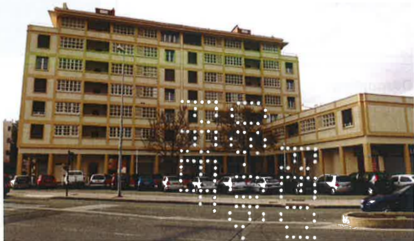
Façade Nord ©Etudes et Planification Mairie Toulon. Février 2014
