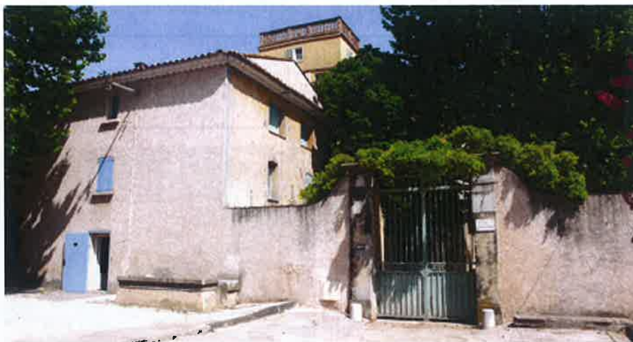
Portail d'entrée, vue générale. Claudine Bron, juillet 2013.
