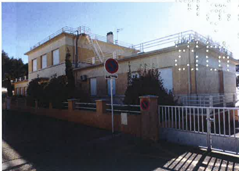
Vue d'ensemble de trois-quarts Nord-Ouest. ©Etudes et Planification Mairie Toulon. Février 2014
