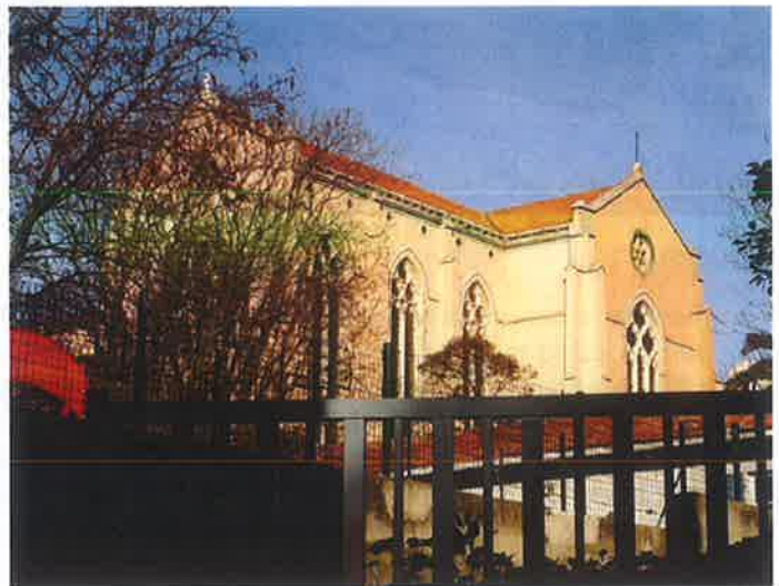
Vue de trois quarts Sud-Ouest. © Archives de la Société des Amis du Vieux Toulon
