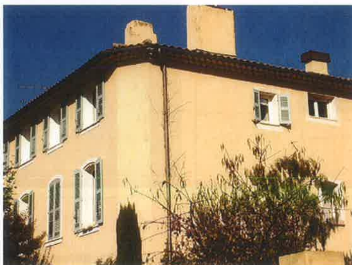
Vue de trois-quarts Sud-Est. ©Ville de Toulon, septembre 2013
