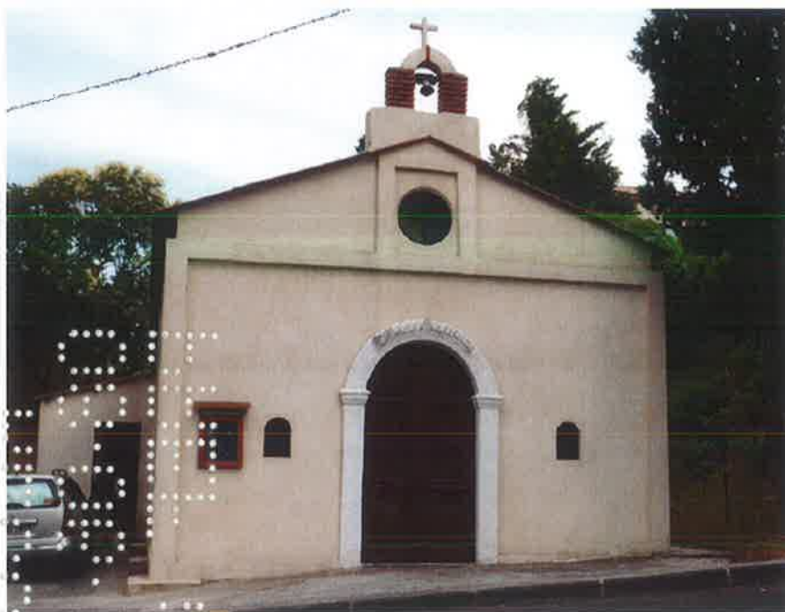
Façade principale Est. ©Claudine Bron, juillet 2013
