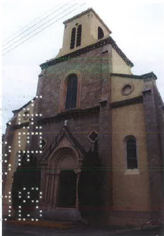
Façade principale Ouest ©Claudine Bron, mai 2013
