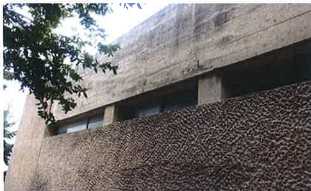
Détail fenêtre en bande ©Claudine Bron, mai 2013
