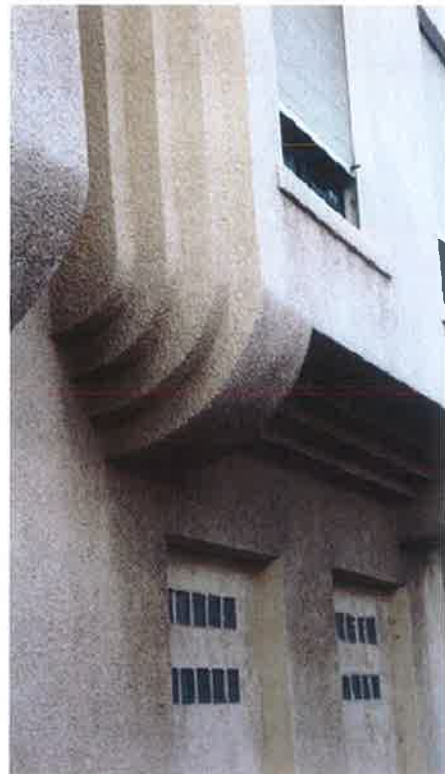
Détail sur corbeaux à ressauts. ©Claudine Bron, juillet 2013
