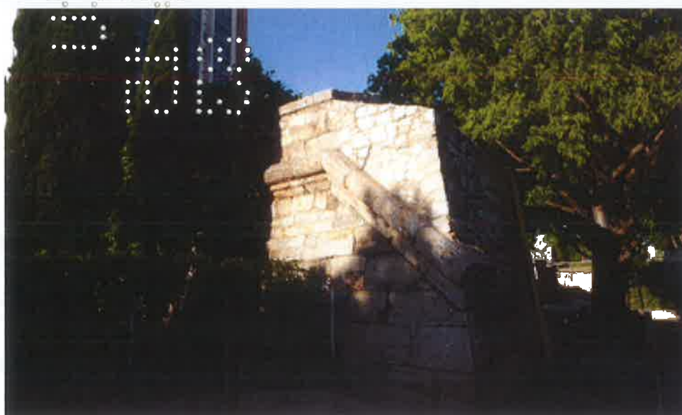
Au premier plan, détail sur l'enceinte bastionnée, à l'arrière, façade Sud d'une des trois tours. ©Claudine Bron, juillet 2013
