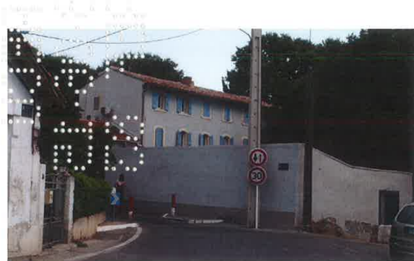
Vue générale de trois-quarts Sud-Ouest. ©Claudine Bron, juillet 2013
