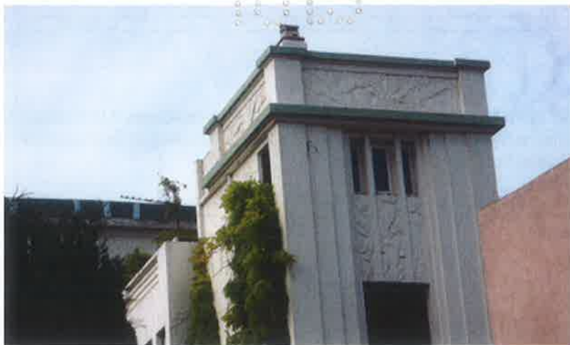
Vue de trois-quart Sud-Ouest. © Claudine Bron, mai 2013
