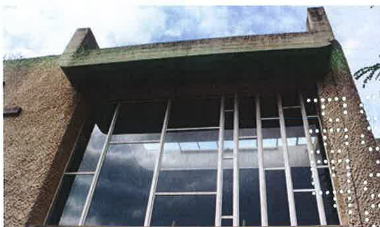
Façade Sud, détail sur verrière du chœur. ©Claudine Bron, mai 2013
