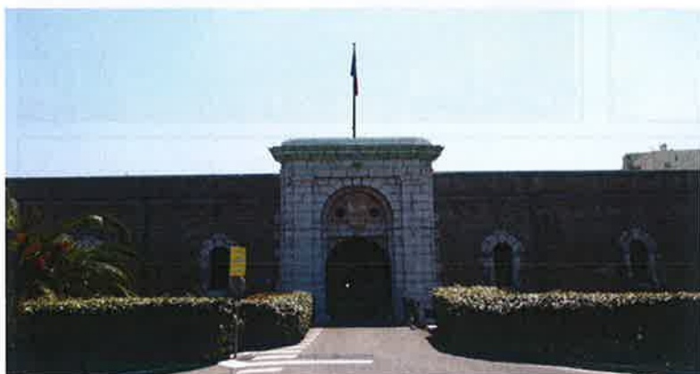
Front Ouest, détail sur porche d'entrée. ©Claudine Bron, juillet 2013
