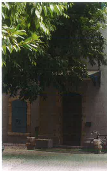
Détail porte d'entrée. ©Claudine Bron, juillet 2013
