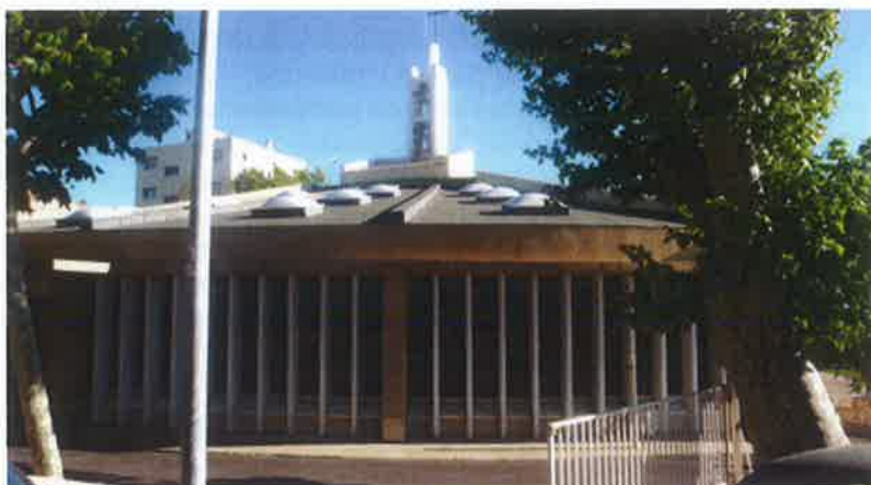
Vue générale, façade d'entrée au Nord. ©Claudine Bron, juillet 2013
